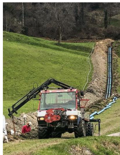
Bereitlegen der Rohre (Parallelleitung DN 250 und DN 150) und anschliessende Verlegearbeiten im Graben des leicht ansteigenden Geländes.
